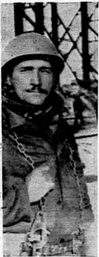
Сдадим главный корпус к 60-летию Великого Октября! Так говорят строители Атоммаша. Этой целью живут монтажники бригады А. Аношкина из «ЮСК». С перевыполнением норм ведет работу монтажники этой бригады В. Ивашкин.
